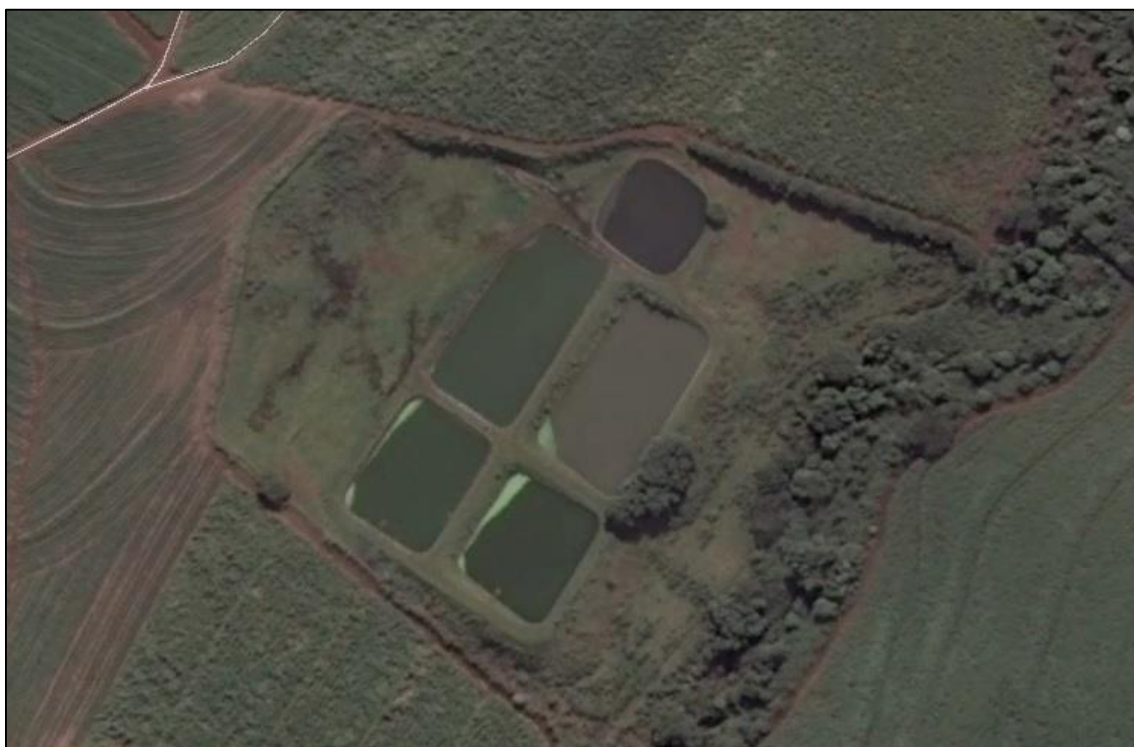
Fotografia 42 - Estação de Tratamento de Esgotos Sonho Nosso.
