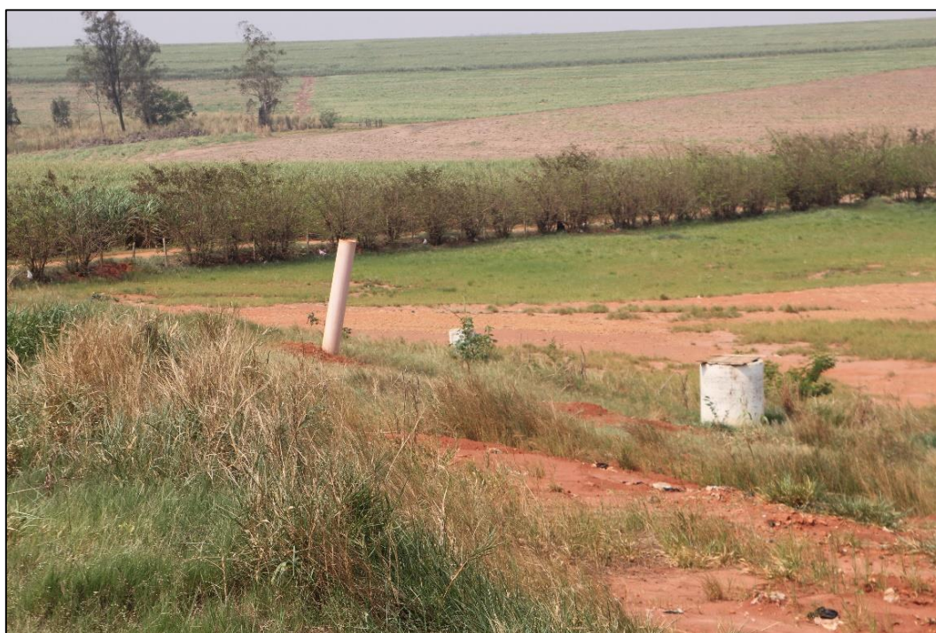
Fotografia 89 - Vista do dreno de metano das duas células finalizadas.
