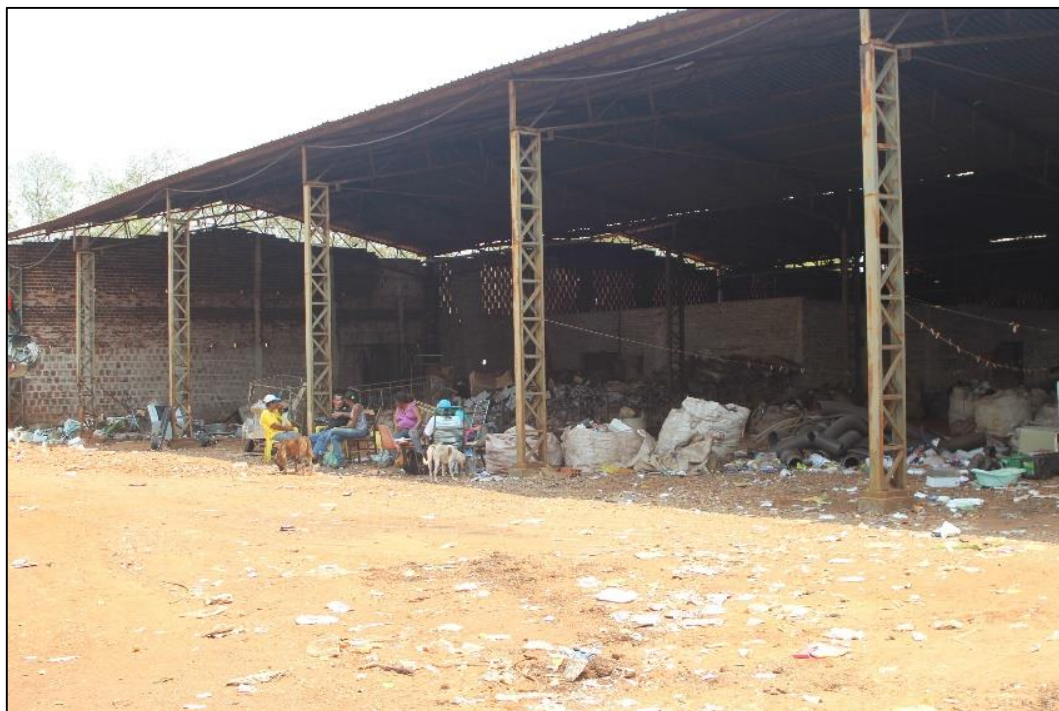
Fotografia 95 - Entrada dos três primeiros galpões da Cooperativa ECOBARRA.
