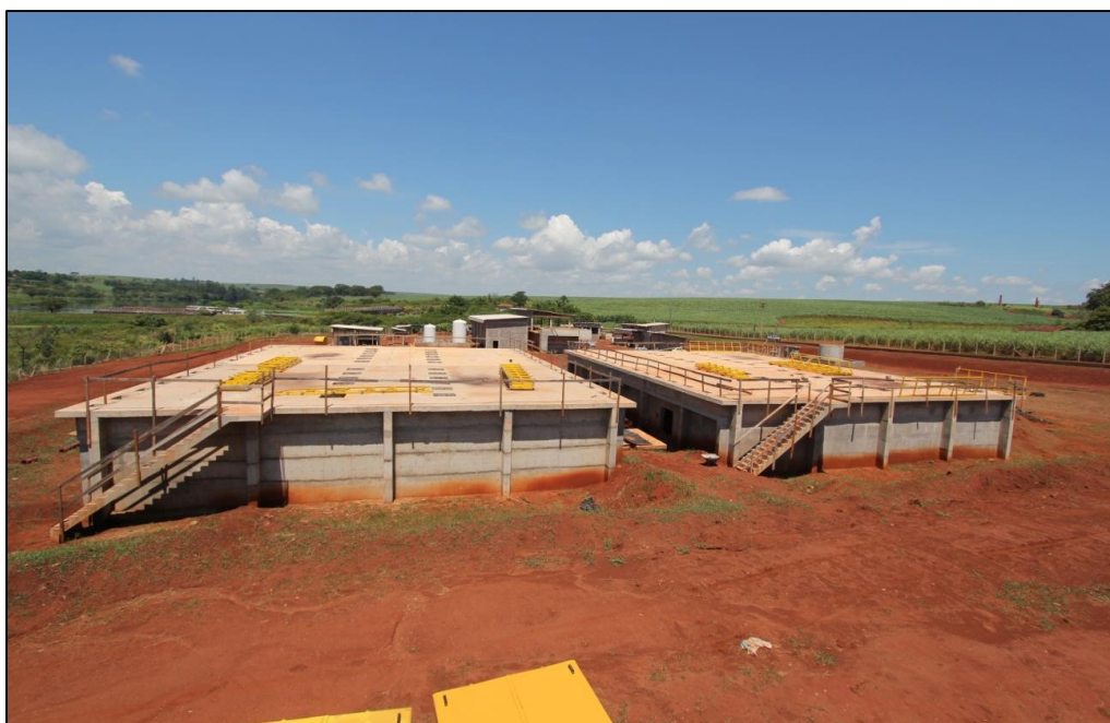
Fotografia 47 - Reatores UASB – ETE Sonho Nosso.
