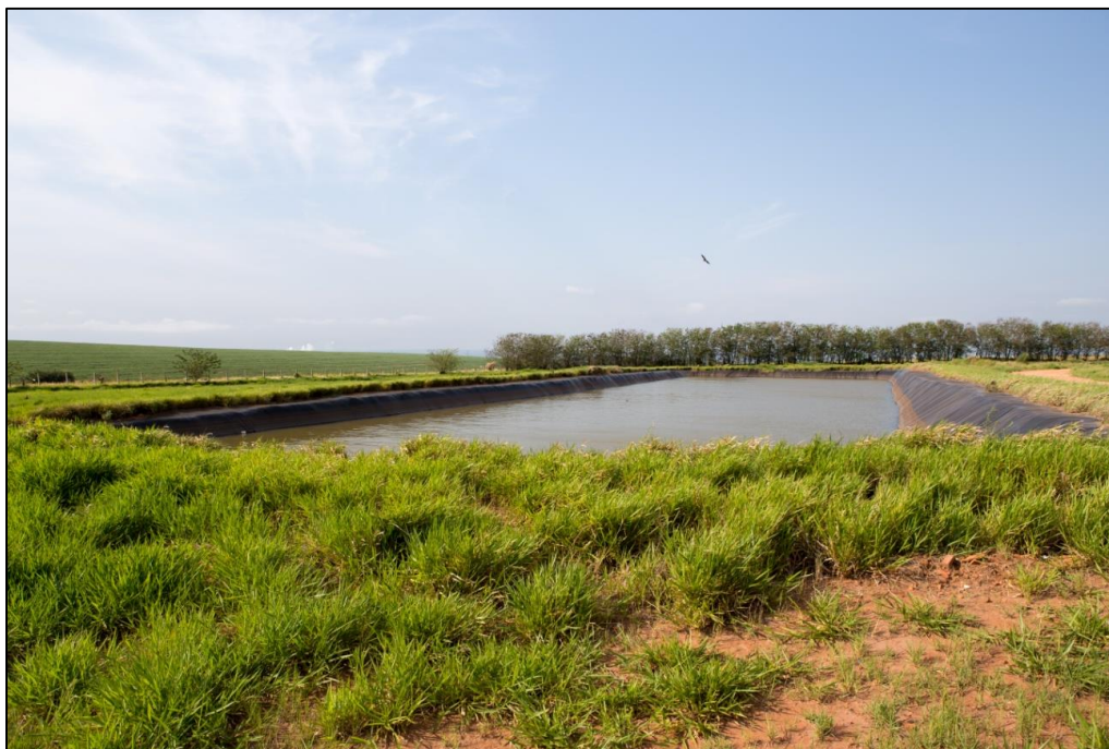
Fotografia 87 - Vista da lagoa de drenagem de chorume.
